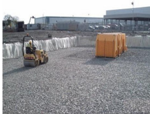
3. Tłuczeń zgęszczamy do min. 95% gęstości standardowej Proctora
