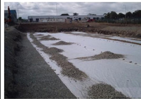
12. Układamy geowłókninę, a nad nią wykonujemy zasypkę, którą zagęszczamy co 15 cm
