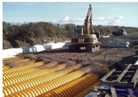
11. Warstwa tłucznia zgodna z projektem, minimum 15 cm
