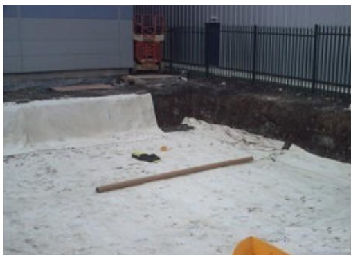
1. Wykonujemy wykop, następnie wykładamy wykop geowłókniną
