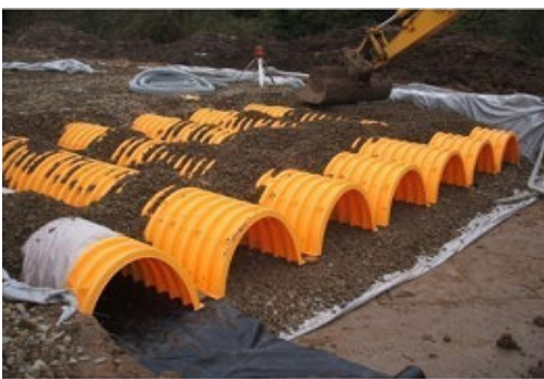
10. Przykrycie systemu wykonujemy za pomocą obsypki z tłucznia
