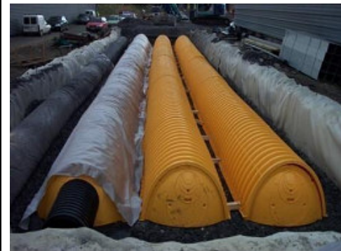
8. W pokrywie skrajnej separatora zanieczyszczeń (Isolator™) montujemy rurę dystrybucyjną
