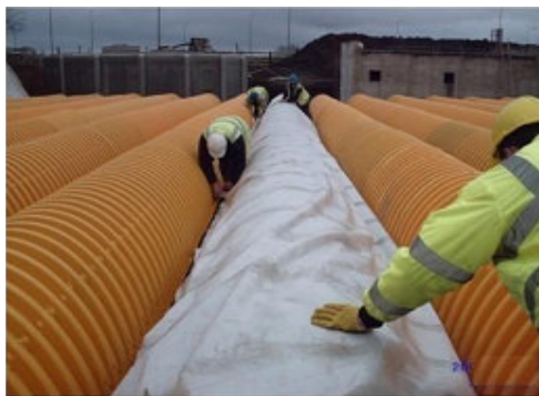
7. Owijamy separator zanieczyszczeń (Isolator™) geowłókniną
