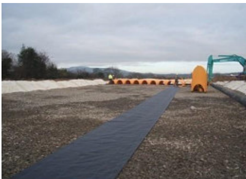
6. Układamy geotkaninę pod separator zanieczyszczeń (Isolator™) wg projektu
