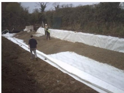
2. Na dnie umieszczamy warstwę minimum 15 cm obsypki z tłucznia (uziarnienie 20÷50 mm)
