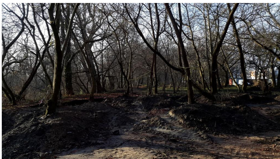
Fot. 5 Teren rekultywacji - sektor I. Widoczne korytowanie w zasięgu brył korzeniowych drzew. Stan z dnia 23.XI.2015 r. Fot. J. Wilkowska
