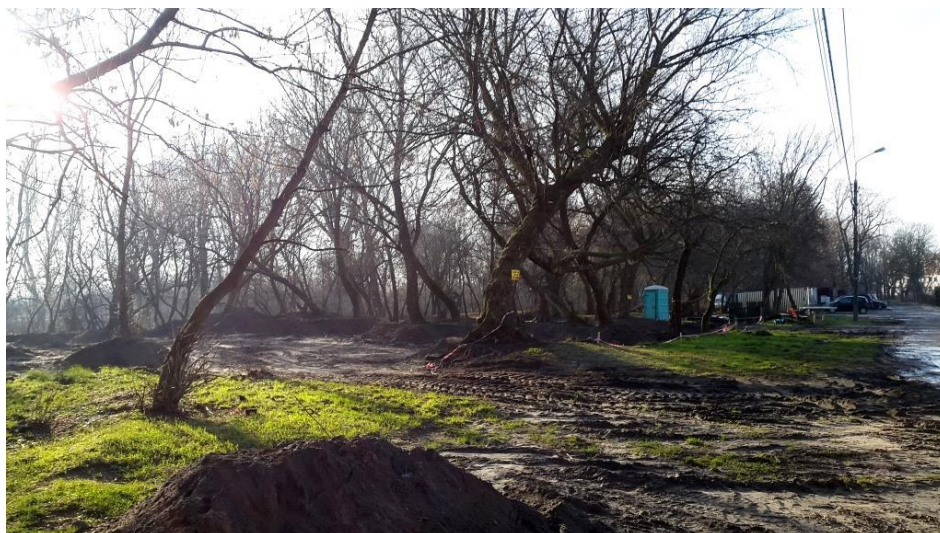
Fot. 4 Teren rekultywacji - sektor I. Widoczne korytowanie o bardzo dużym stopniu ingerencji w systemy korzeniowe drzew. Silna redukcja brył zagrażająca statyce drzew. Stan z dnia 23.XI.2015 r. Fot. J. Wilkowska
