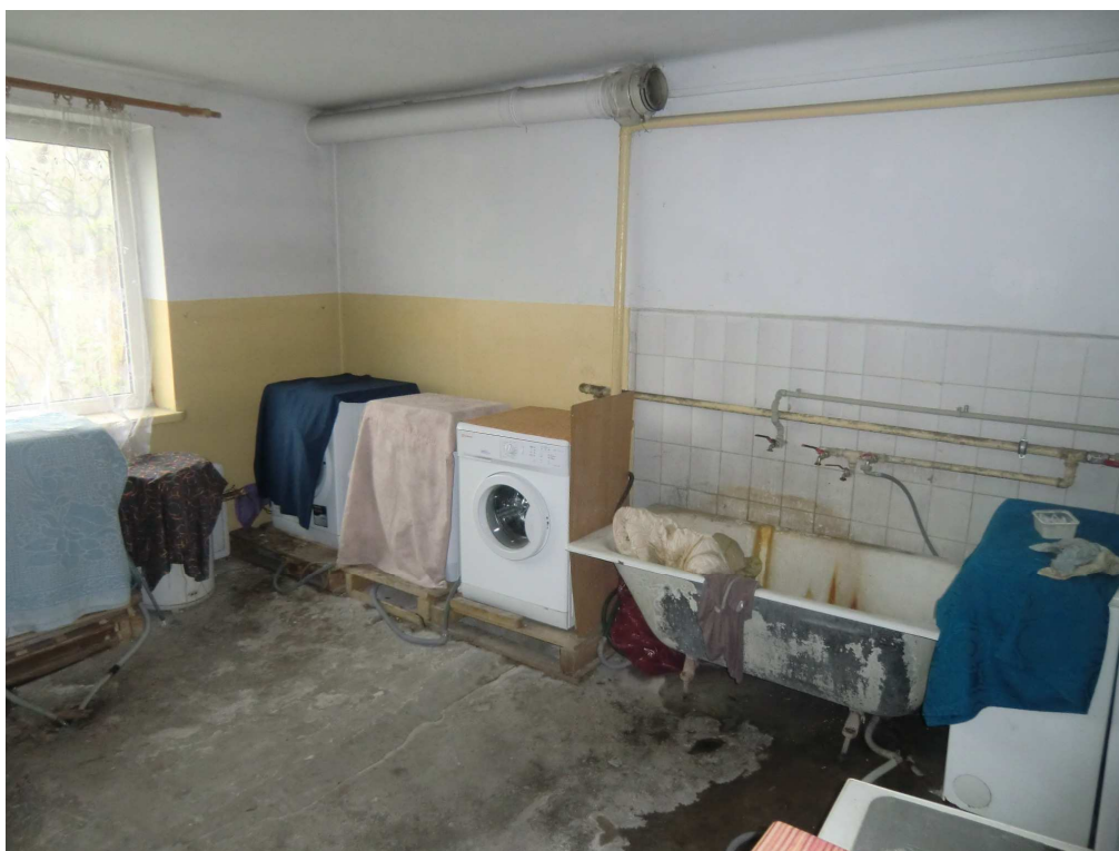
Zdjęcie 5 Pralnia w budynku komunalnym przy ul. Fabrycznej 2
