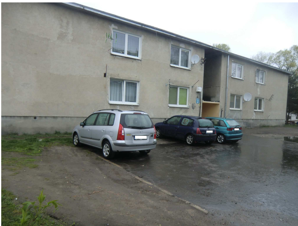
Zdjęcie 4 Budynek komunalny przy u. Fabrycznej 2
