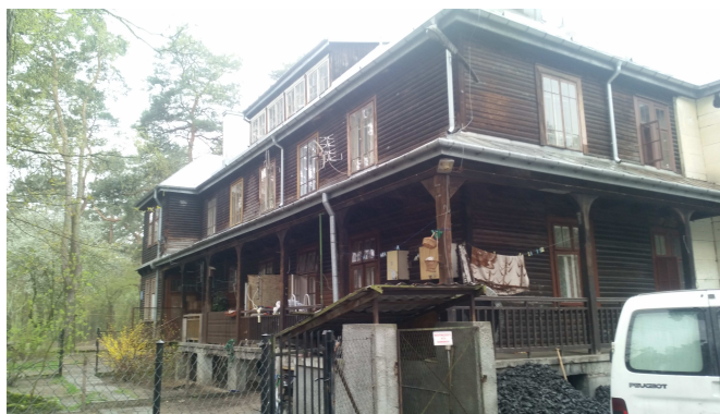
Zdjęcie 2 Budynek komunalny przy ul. Pionierów 38
