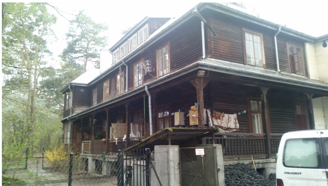
Zdjęcie 6 Budynek komunalny przy ul. Pionierów 38
