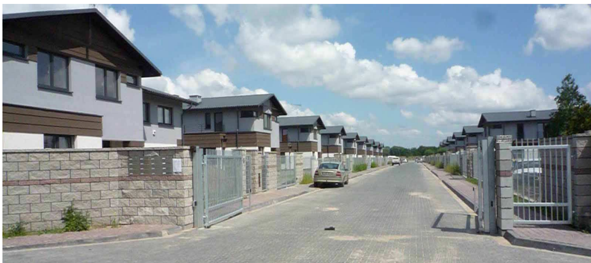
Zdj. 13 Nowe osiedle mieszkaniowe domów jednorodzinnych
