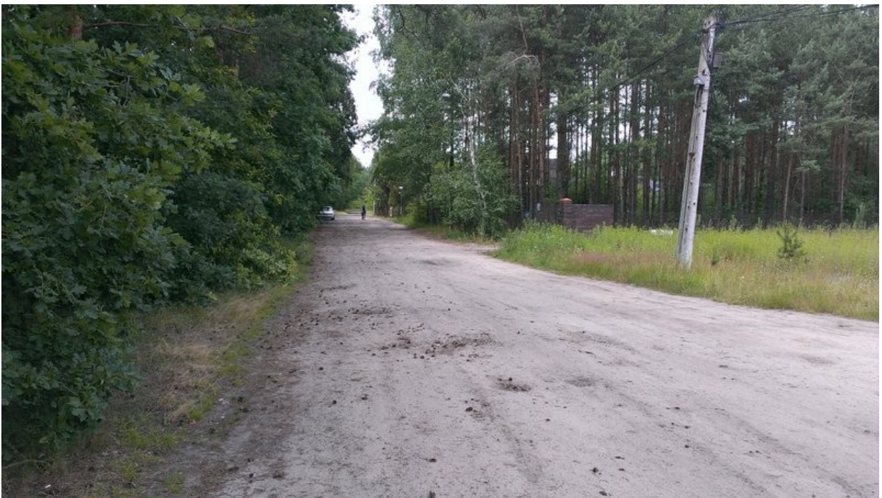
Ilustracja 32: Nawierzchnia tłuczniowa o szerokości 6 m.
