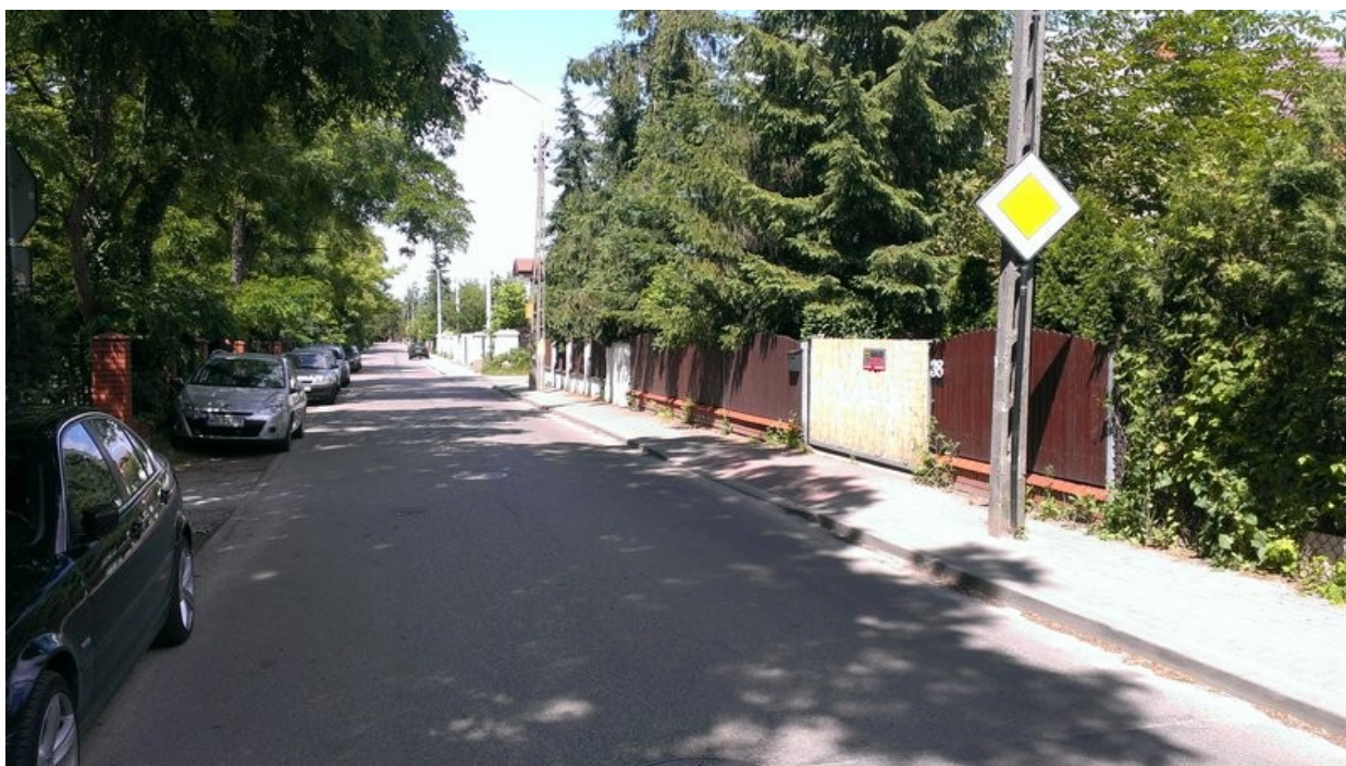
Ilustracja 9: Przekrój ul. Dolnej, liczne parkujące samochody zawężają pas ruchu ograniczając prędkość pojazdów.
