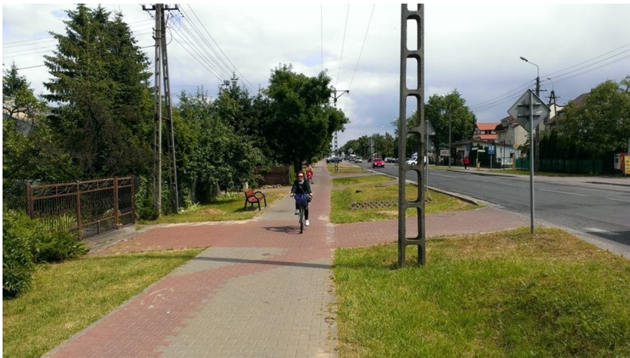
Ilustracja 39: Brak wyokrąglenia łuków oraz zbyt wąska DDR wzdłuż ul. Warszawskiej.
