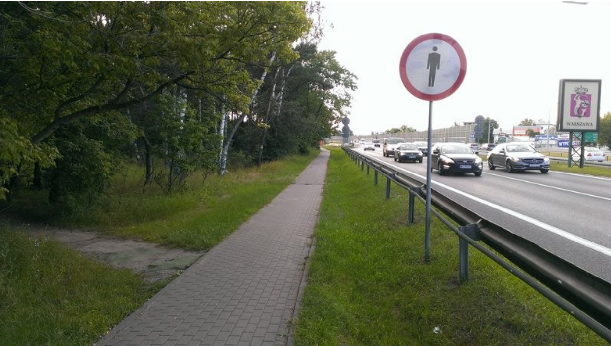
Ilustracja 27: Chodnik łączący przejście dla pieszych przez DK7 z ul. Pancerni wymaga poszerzenia.
