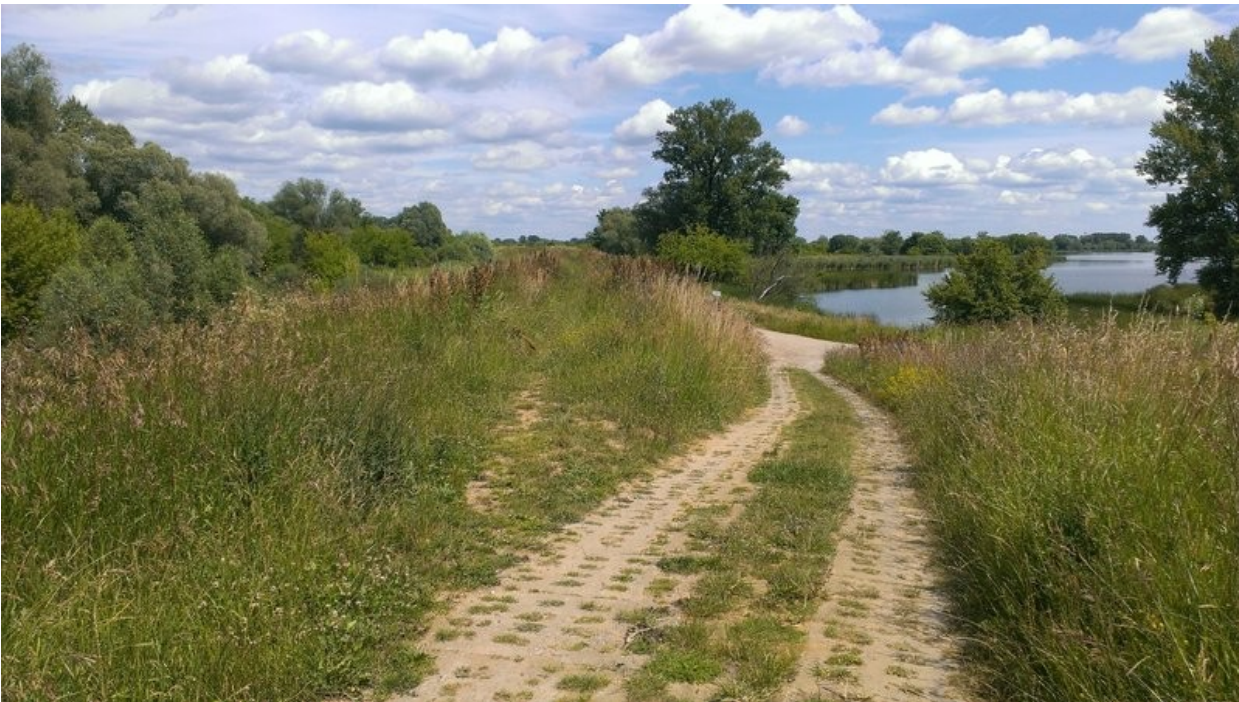
Ilustracja 57: Najazd na wał Wisły, widok z wału w kierunku odcinka (37).
