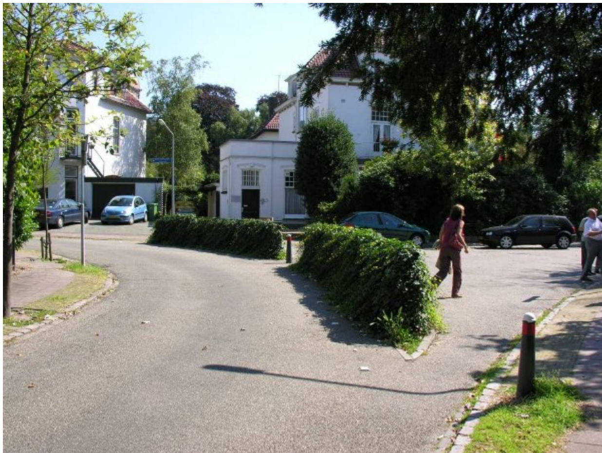
Ilustracja 2: Jedna z form rozcięcia skrzyżowania uniemożliwiającego przejazd samochodem a umożliwiające przejazd rowerem.
