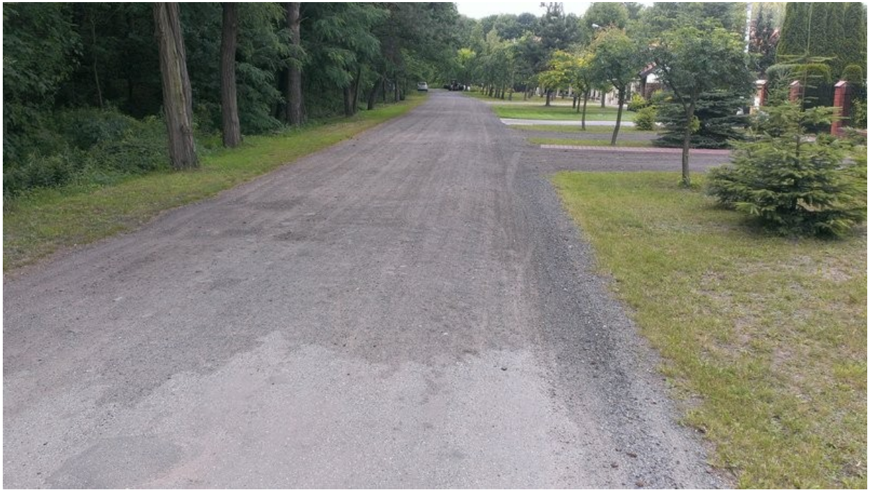
Ilustracja 23: Końcowy odcinek ul. Lutza o nawierzchni tłuczniowej.
