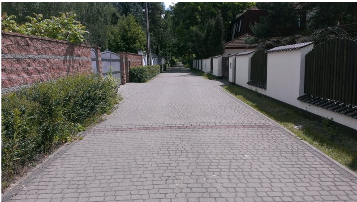
Ilustracja 15: Nawierzchnia z kostki betonowej na odcinku ul. Kampinoskiej.
