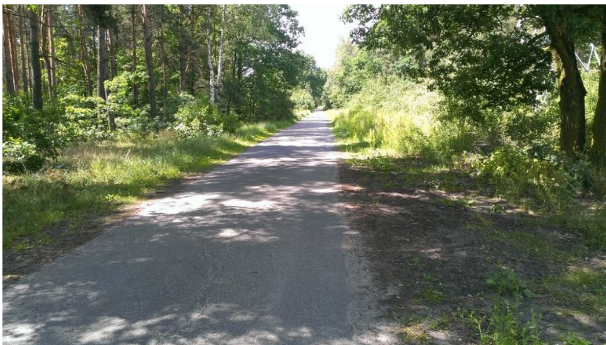
Ilustracja 12: Asfaltowy odcinek ul. Pancierz.
