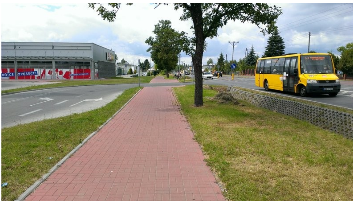
Ilustracja 65: Pas drogowy ul. Warszawskiej po stronie południowej pozwala na wydzielenie infrastruktury rowerowej.
