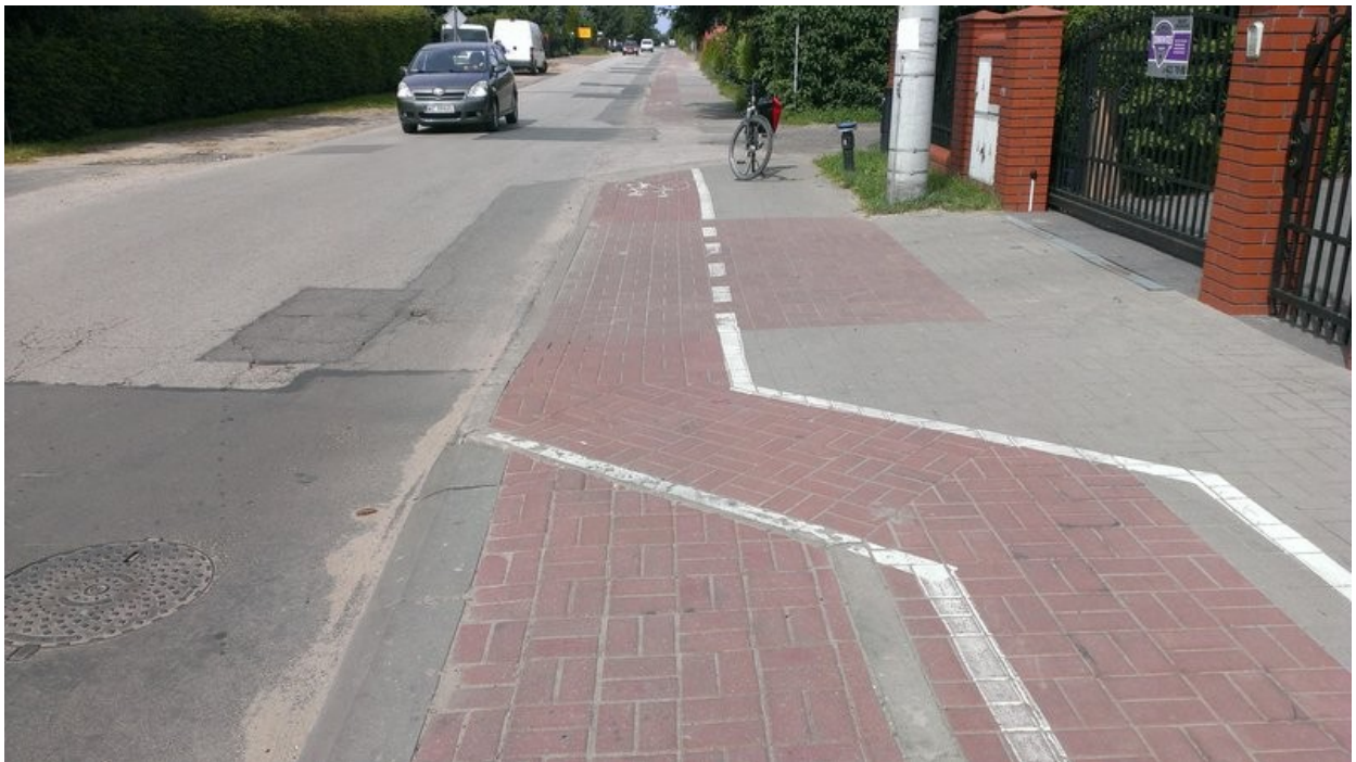
Ilustracja 45: Brak łagodnych łuków na DDR - rower nie może skręcić w miejscu.
