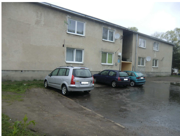
Budynek komunalny przy ul. Fabrycznej 2
