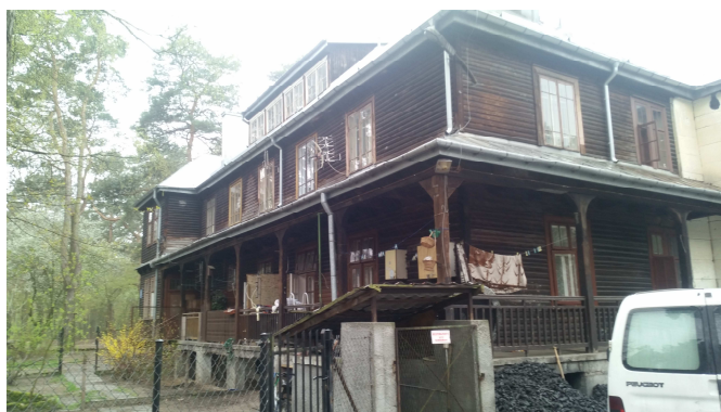
Budynek komunalny przy ul. Pionierów 38
