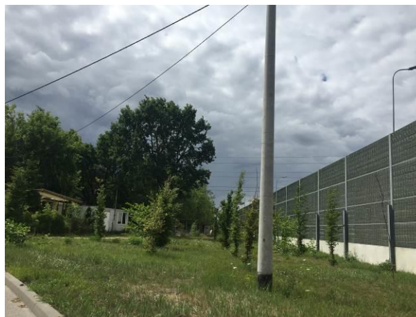
Fot. 6 Ekran akustyczny przy drodze krajowej nr 7 – widok od ul. Glinianki (fot. Joanna Moczulska)
