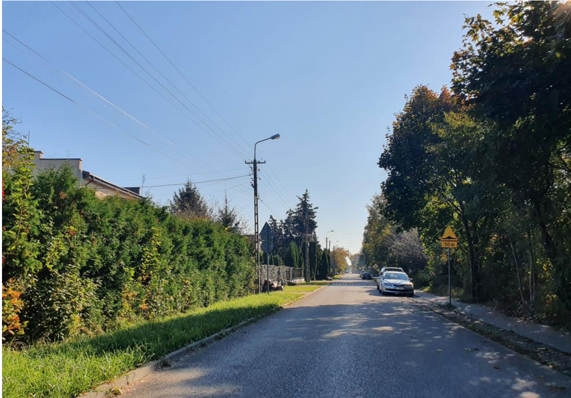
Rycina 27. Drogi lokalne, dojazdowe, z wąskim poboczem i chodnikiem jednostronnym (fot. ERS).
