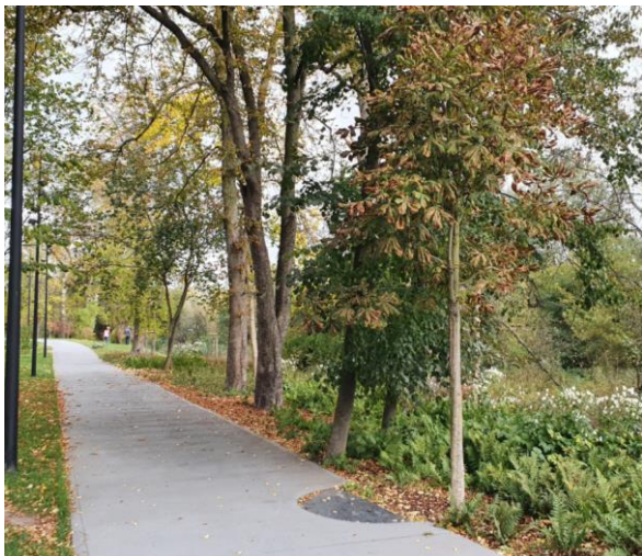
Rycina 56. Drzewa w pobliżu ścieżek z nieprzepuszczalną nawierzchnią, możliwe uszkodzenie korzeni podczas robót drogowych. Stan drzew średni (fot. ERS).
