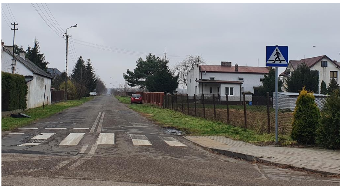
Ryc. 38. Ulica Wędkarska z nawierzchnią bitumiczną w złym stanie technicznym z obustronnym poboczem trawiastym pozbawionym chodnika i drzew (fot. ERS).
