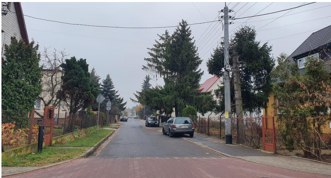
Rycina 25. Bitumiczne drogi, strefowo z kostki brukowej, zjednostronny chodnik i wąskim poboczem pozbawionym drzew (fot. ERS).
