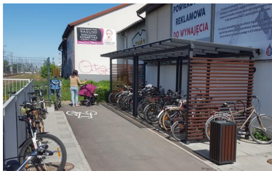
Rys. 7.2 Zadaszony parking B+R w Wołominie
