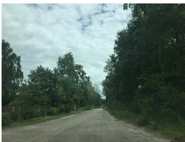
Fot.5 Gruntowa droga – ul. Stary Tor (fot. Joanna Moczulska)
